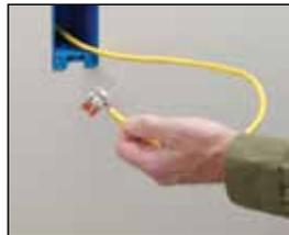
2. Determine wiring scheme. Dress all four pairs (eight wires).
